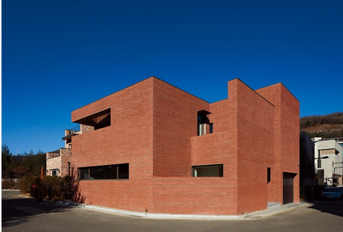
대지 형태를 따라 지은 집. 사선으로 만나는 지점에도 군더더기 없이 이어지는 벽돌 마감의 완성도가 놀랍다.
